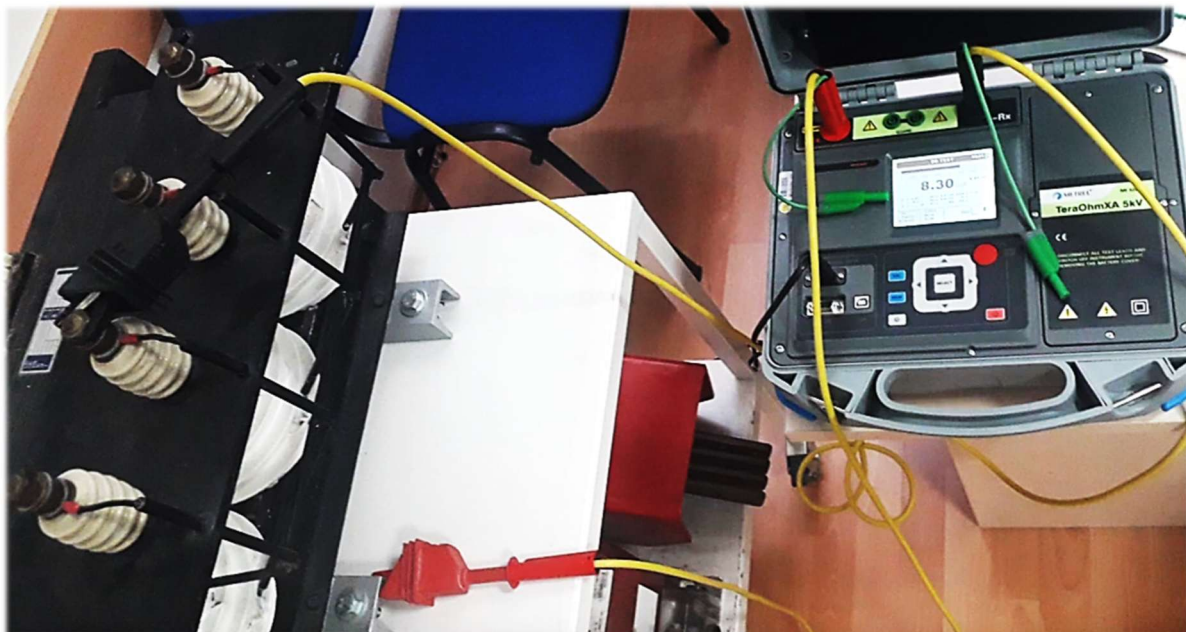
Slika 2.24 Ispitivanje otpora izolacije namota transformatora nazivnog napona 7kV
